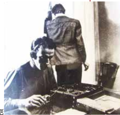
Depuis un appartement situé en ville, un opérateur radio clandestin transmet des messages à sa centrale à l'aide d'un poste émetteur-récepteur valise type B mark II. D'origine inconnue, ce document est très probablement une scène reconstituée. La présence d'un agent de protection à la fenêtre chargé de repérer un véhicule radiogoniométrique correspond à une situation idéale qui ne fut sans doute pas la plus fréquente.
