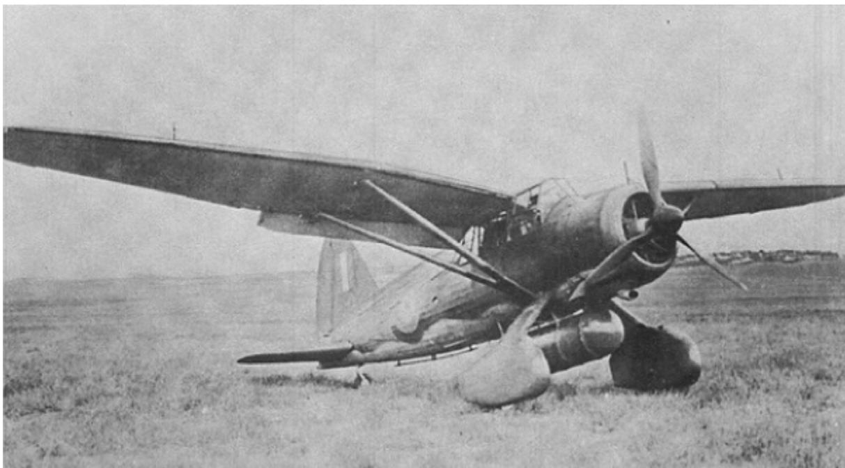
Des mitrailleuses et des petites bombes pouvaient être fixées sous des ailettes placées sur le côté extérieur du carénage des roues.
