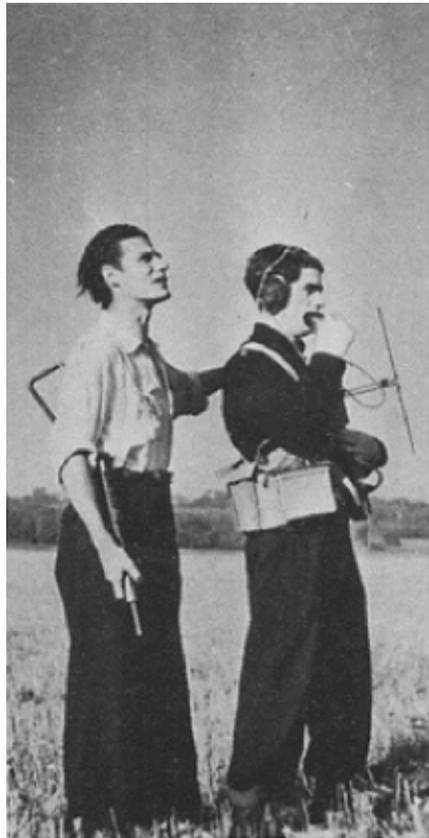
Sa portée est difficile à définir avec précision tant elle est changeante. Un avion à haute altitude se trouvant face à l'opérateur peut capter son émission à plus de 60 km. Mais sur le plan pratique, étant donné la hauteur de vol d'un avion qui recherche un terrain et le fait que l'opérateur ignore cette présence et ne peut donc faire face, on peut dire qu'elle est, en moyenne, qu'une quinzaine de kilomètres.
